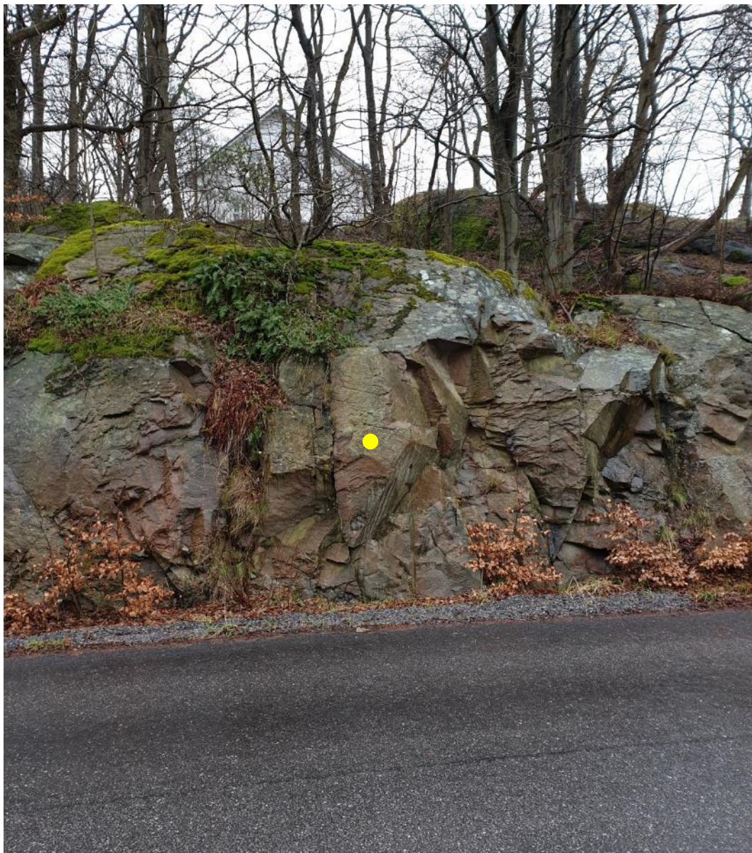
Figur 6. Bild på skärningen vid St. Jörgens väg. Utmarkerat med gul cirkel är ett block som potentiellt kan påverkas av vibrationsalstrande arbete.
