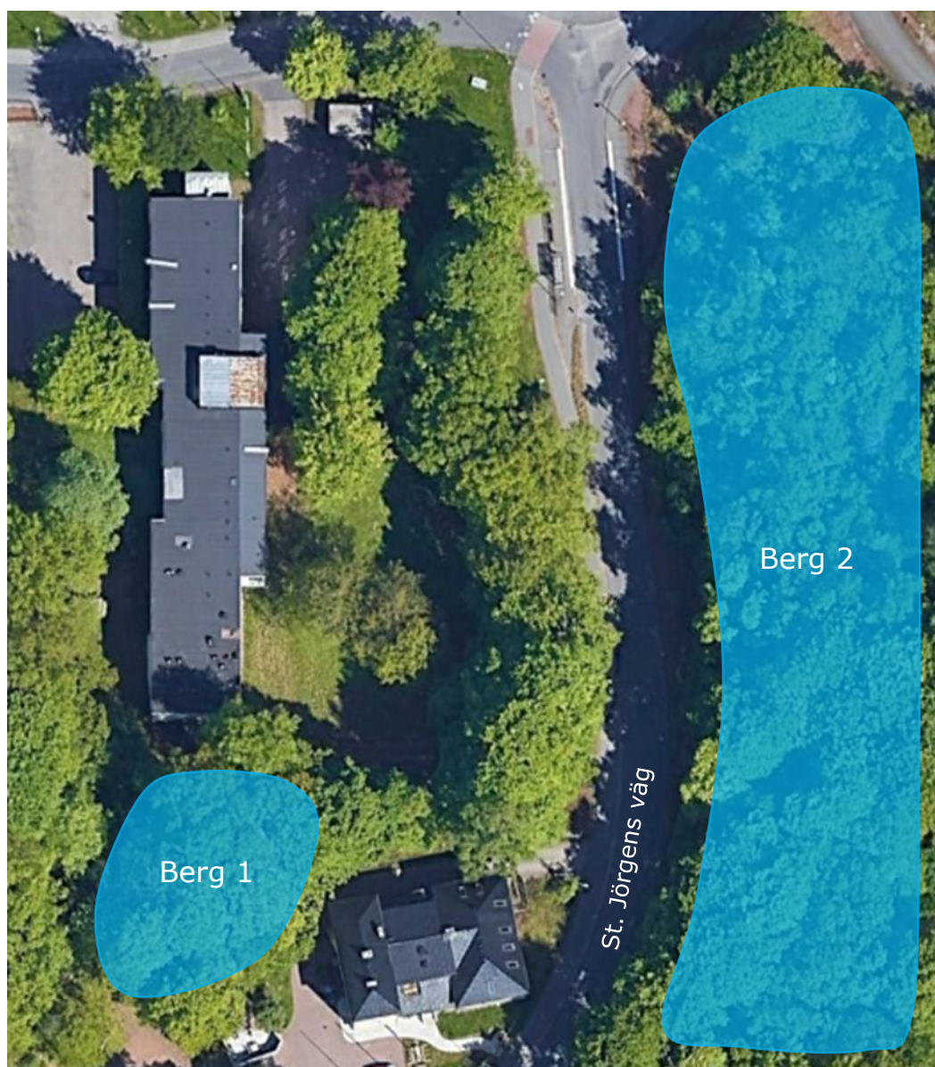
Figur 1. Översiktsskild av läget för bergskärningarna nära Sankt Jörgens Väg i Lillhagen. Det blåa markerar ungefärlig position för de inspekterade bergslänterna.
